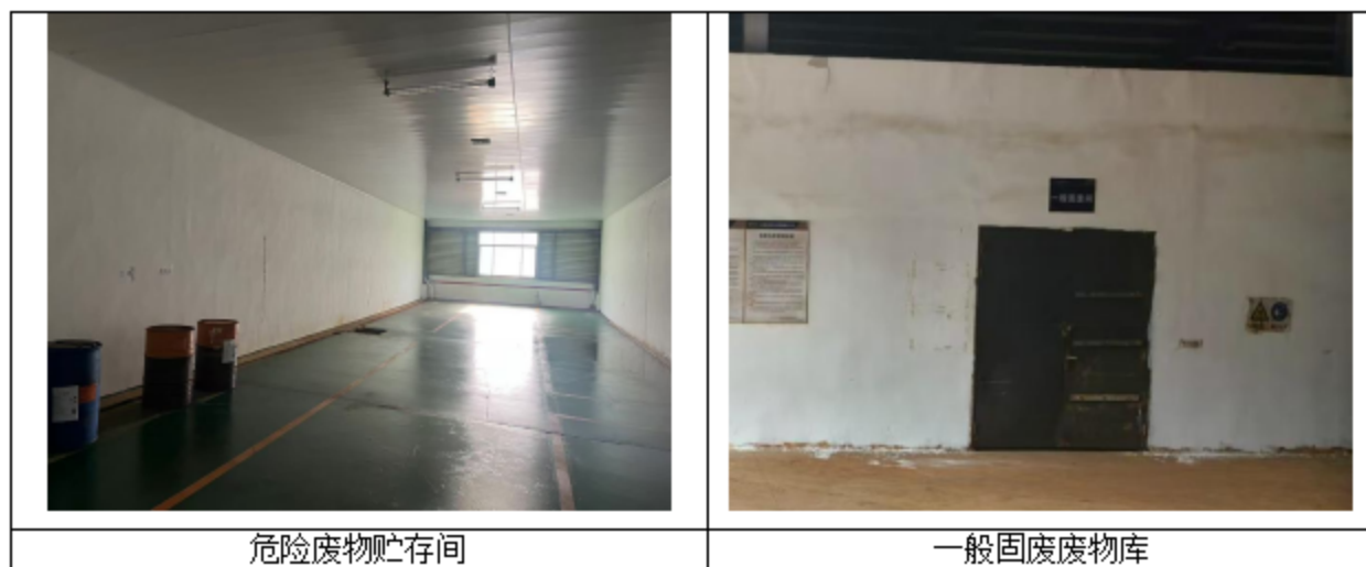
图 4.1-8 固体废物暂存设施
